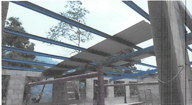
Foto 4: Sustitución de soporte de metal.
