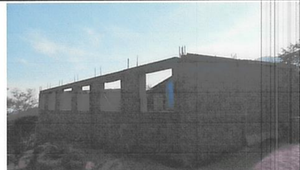
Foto 6: Construcción de ventanas.
