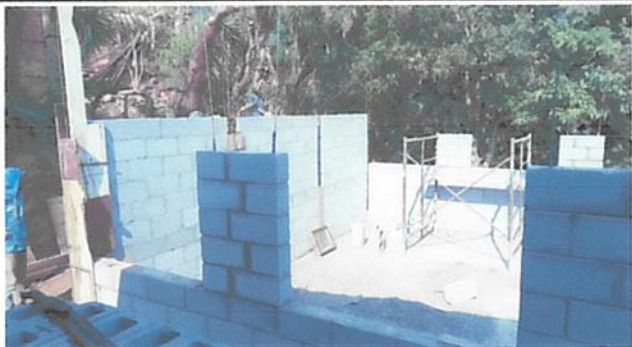
Foto 3: construcción de ventanales.
