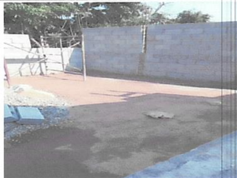
Foto 2: Sustitución de paredes por block.
