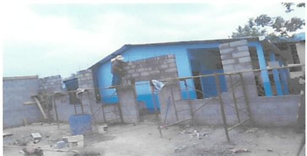
Foto 5: Construcción de puertas.
