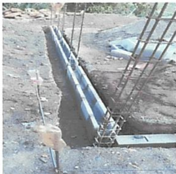
Foto 1: Levantado de paredes.
